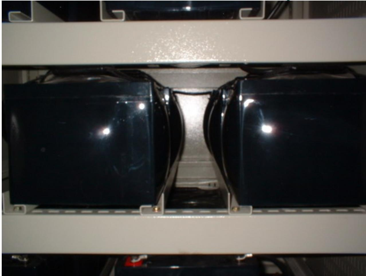
**Thermal runaway** ก็อ อาการที่แบตเตอรี่ ร้อนและบวมในขณะชาร์จ ซึ่งทำให้แบตเตอรี่เสียไปที่สุด
